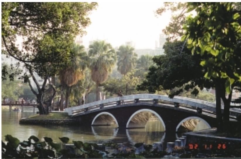
台中公園水泥拱橋
