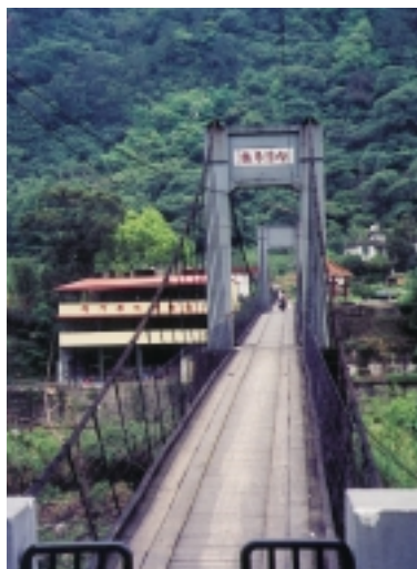
內灣地標——內灣吊橋
