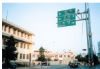
金門新街上的現代建築林立
