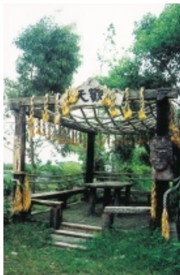
利用廢枕木與繩索搭成的 「觀天亭」
