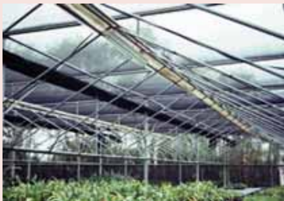
遮陽防護設施
