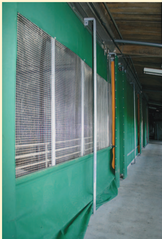
自動化負壓保育豬舍外貌
