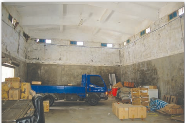
海之十號倉庫的厚牆與半天高氣窗，見證農村發展與時代變遷
