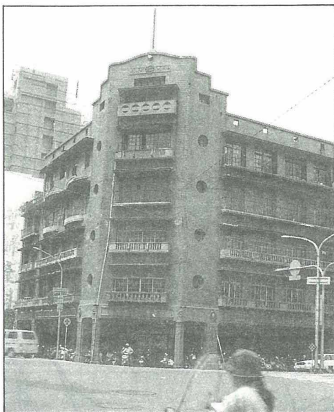
民國81年的同一棟建築，繁華落盡，人去樓空，老屋命運無人知。
