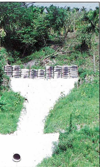
道路排水以輪胎填配合排水路面處理，比使用涵管排水效果更佳。
