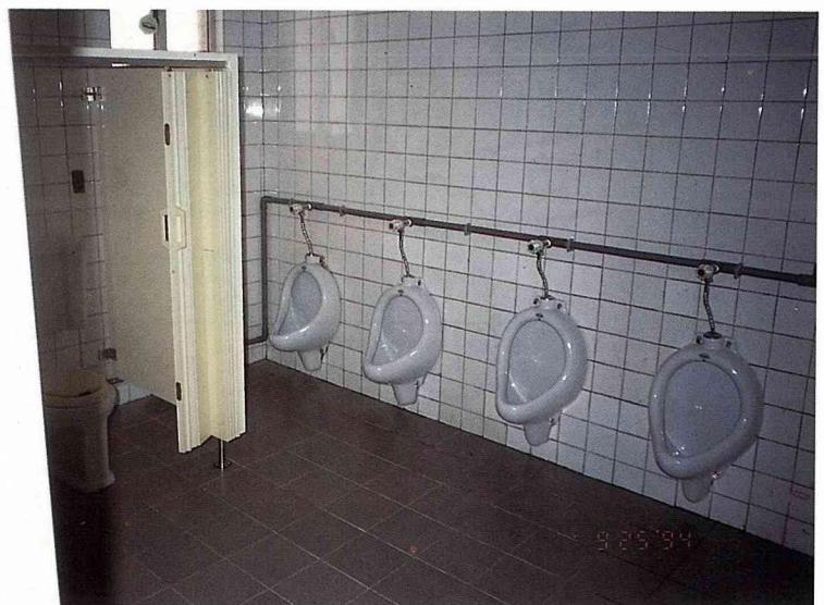
廁所設計避免傳統溝式尿槽的髒臭
