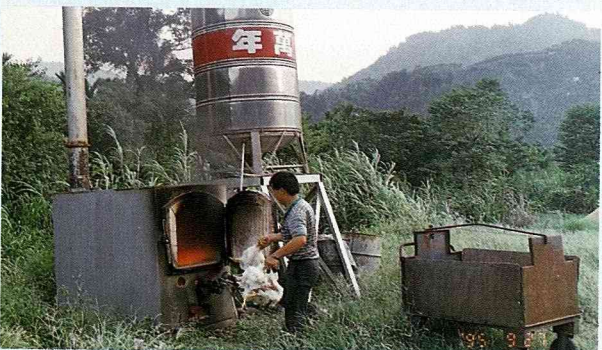
補助設置焚化爐處理病死雞
