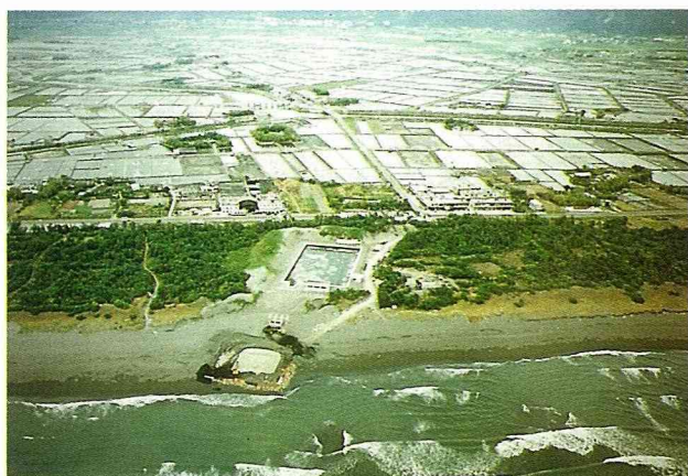
宜蘭礁溪大塢養殖區海水抽水站。興建共同供水設施 避免養殖業者個別抽用地下水。(圖／宜蘭縣政府)
