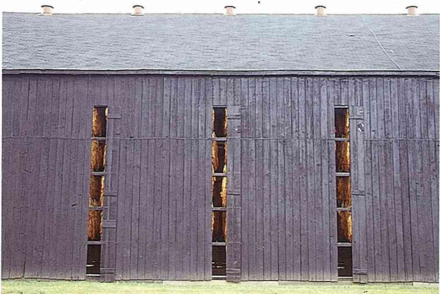
傳統菸草乾燥室的通風通氣方式
