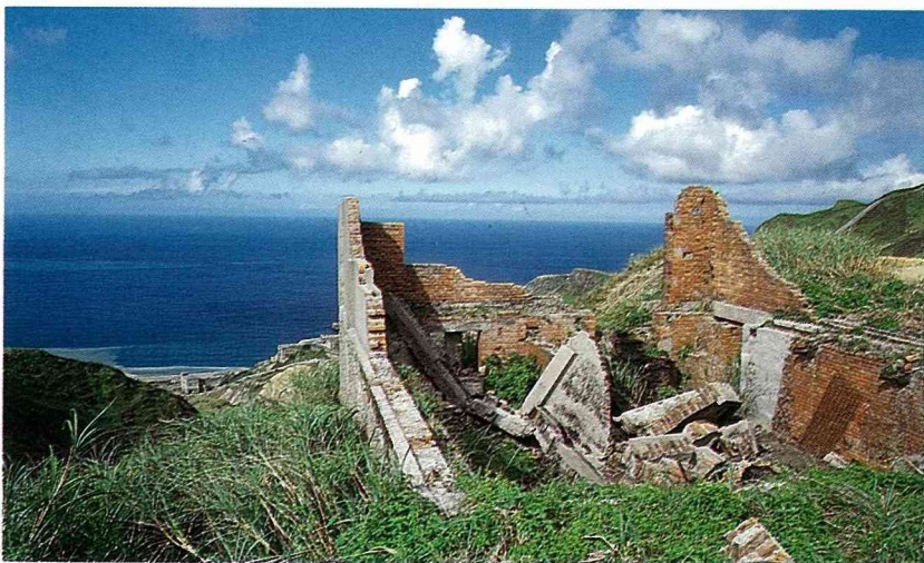
■六坑已經塌損。
