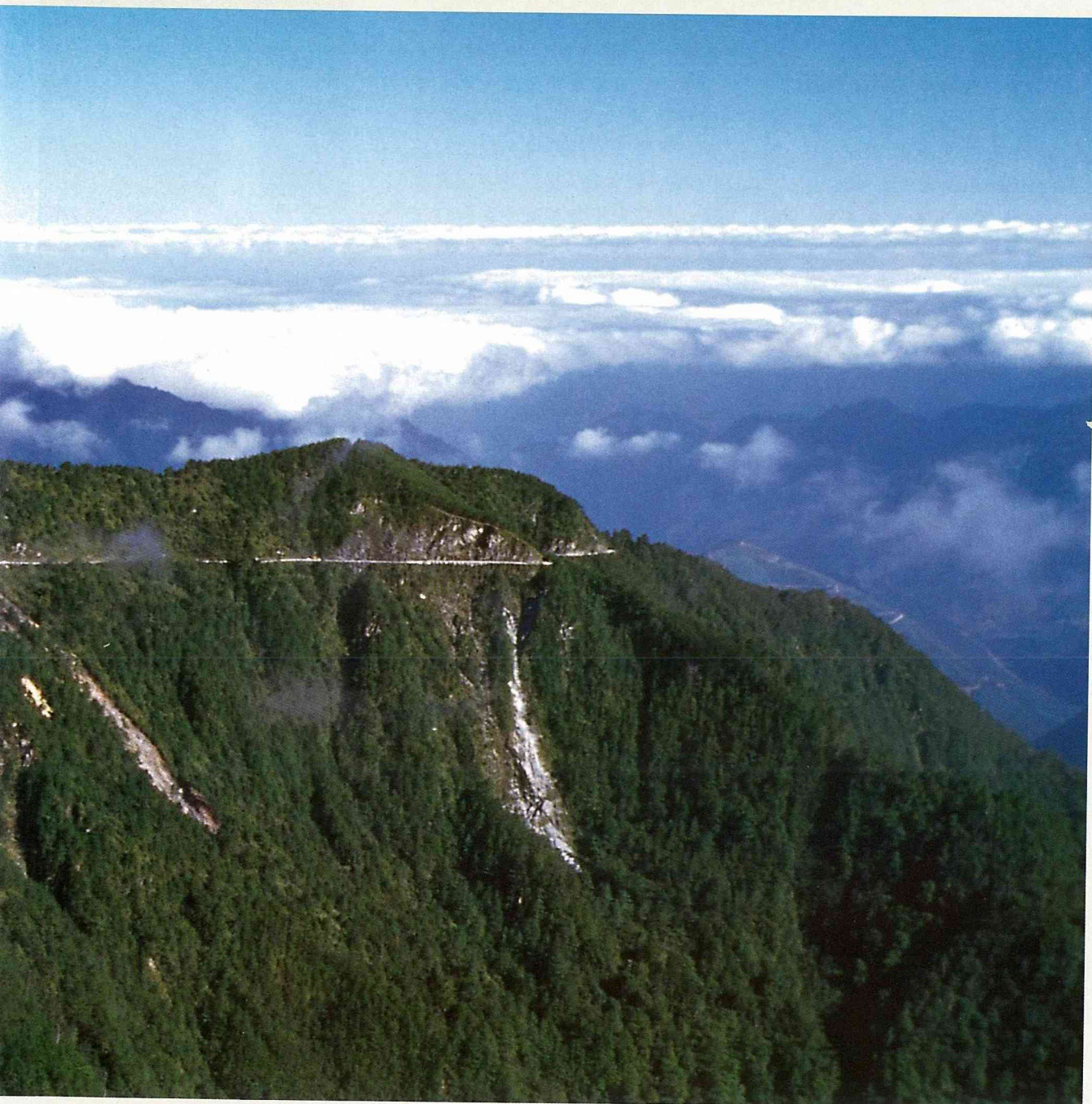
■南橫公路沿著峭壁開挖，工程艱鉅而浩大。
