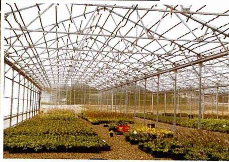
◀Valleybrook 最新的溫室設備，購自 Cravo 公司，屋頂可分區打開。夏天很熱時，除將屋頂打開，並用微灌溉系統降低溫度。
