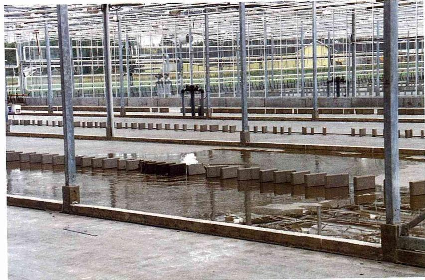
■溫室地面出水灌溉情形。地面是設計成兩邊微高，向中間傾斜，出水和收水都從中間的灌溉溝，灌溉時加水到2.5公分高時即排水，中間的磚塊只是防止大件雜物掉入管道中，新近加蓋的溫室已將灌溉溝設計得更窄，不需要這麼多磚塊。灌溉用水經過濾消毒後可重新使用。
