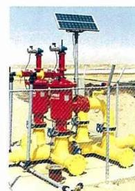
一般濾水機通常採用多相調整裝置，以增大工作容量，因此也易於發生故障。愛密爾得式8~14噸濾水機，為市售單式濾水機中，容量最大的一種。機械性能：可應付每小時達1000立方公尺且嚴重污染的水流，過濾面積可達10,000平方公分。過濾指數自3500至10μ，可與砂礫式濾水機相比。此外，還有一項特色，就是操作時完全由精確電腦程式(P.L.C.)控制，迅速反應到機械各部份。任何情況改變時，
