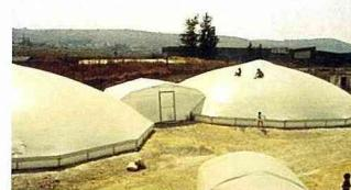
兩年前發展完成的第一座氣囊式魚塭，那時先要挖掘地面，然後埋下主槽，如遇到岩礫層就無法裝置，同時還有抽去積水的問題。那時的主槽還是傾斜的槽壁，因此減少了魚塭的容積。最新型的氣囊魚塭已改進為垂直槽壁；平放在地面上，不必挖掘。魚塭寬度的規格最大的達40公尺。
