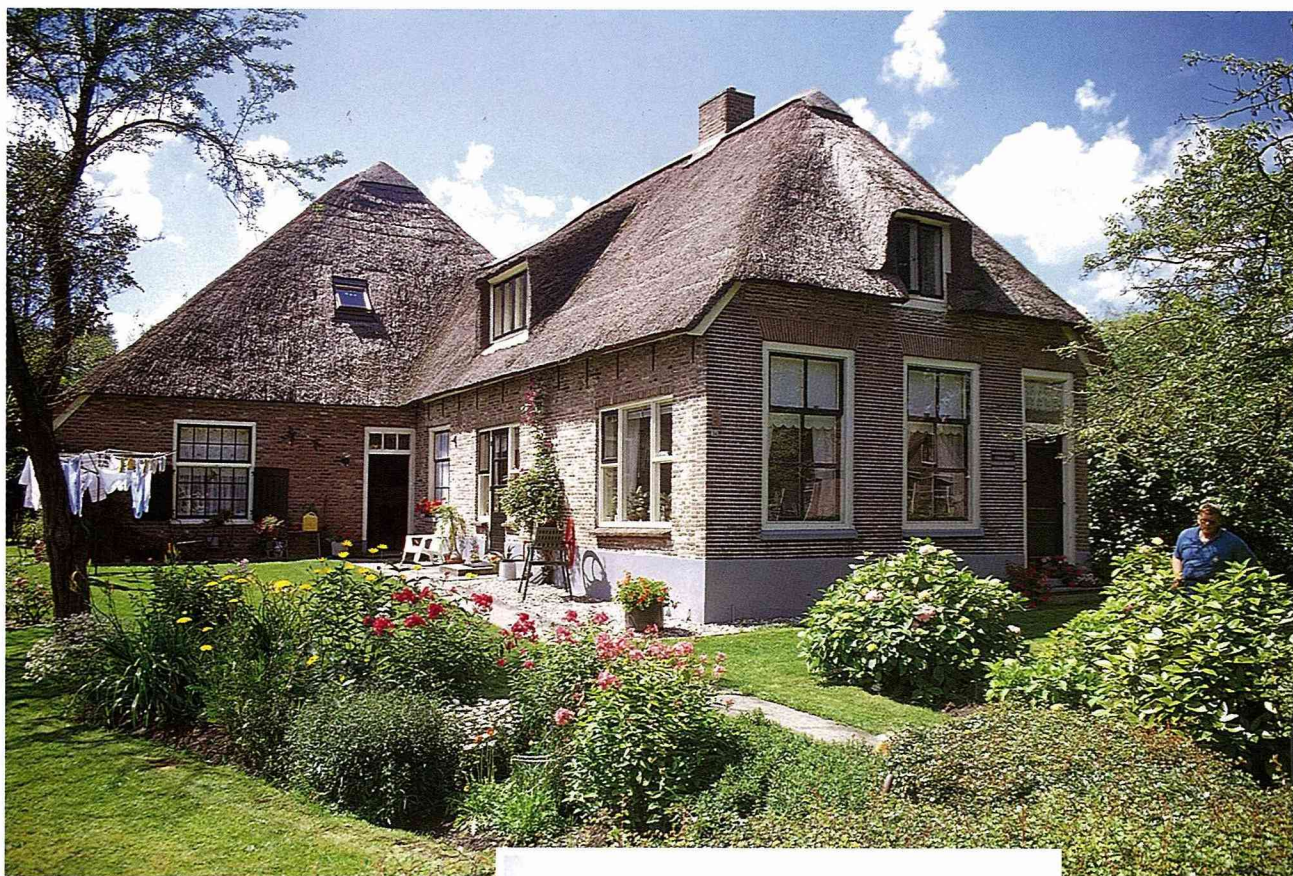
■ 建築中的「現代魯濱遜」——茅草屋頂住宅。
