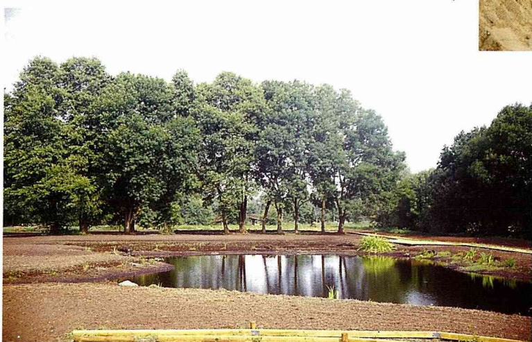
■ 雨水滯留池，發揮涵養水源的功能。
