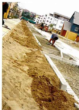
■ 施工中的滲水土溝。(余淑蓮 / 攝)
