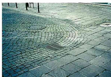
■車道、排水溝、人行步道的鋪面，採用不同的透水磚，呈現圖案之美。
