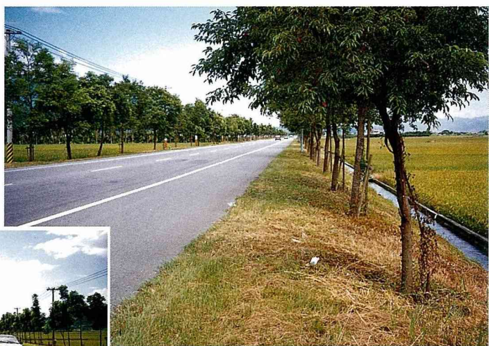
■路面排水經植生帶過濾之後，再流入排水溝。 (台九公路300K 玉里附近)
