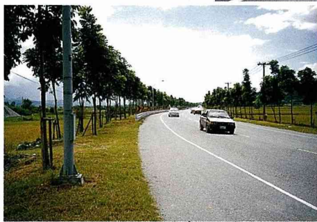
■路面排水經植生帶過濾之後，再流入排水溝。 (台九公路300K 玉里附近)
