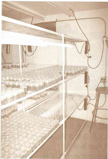
■ 培養室一角，美國的日光燈大多用ballast啟動，右方角落的黑色金屬盒子，盒子通電時會產生高溫，因此通常把ballast從燈具中移出來，架到側邊或天花板上，以免局部高溫把組織培養苗「煮熟」了。
