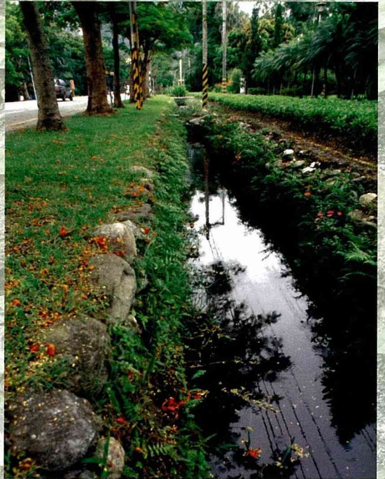
■路旁的土溝既能排水，也能滲入地下，補充地下水。 (地點：花蓮台九公路193-194K段 / 大魯閣國家公園提供)
