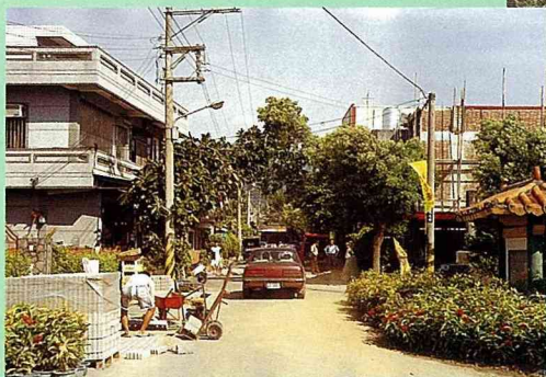
■植草磚施工情形。
