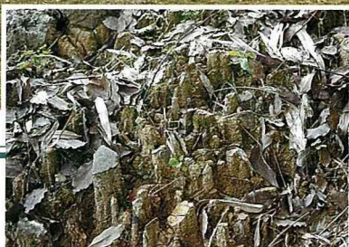
■山坡地邊坡土壤遭沖蝕，形成小型石林圖。
