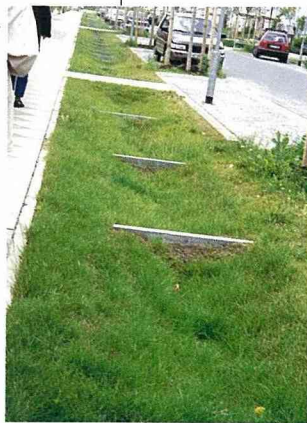
為涵養社區地下水源，科貝城的排水溝有獨到的截流設計。
