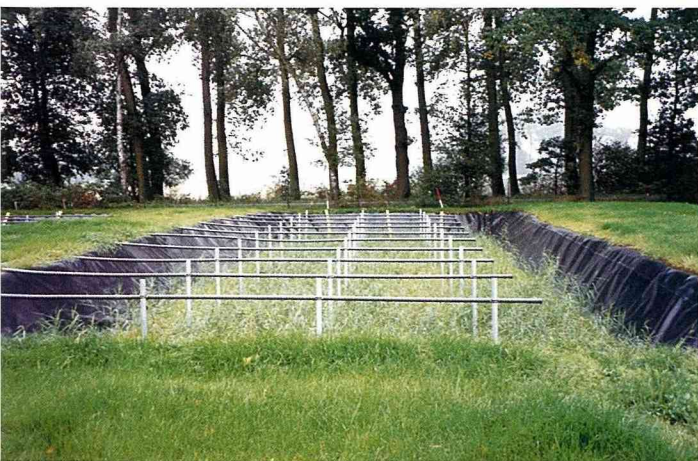
■兩座約 50 立方公尺的蘆葦池，再處理全村的固體污泥。
