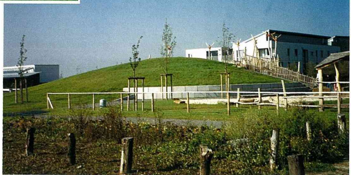
綠意盎然的草坡之下，其實是一座太陽能加熱貯水槽，旁邊規劃為兒童遊戲場。
