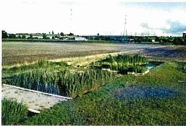
■圖5.水平式的人工溼地污水處理系統。
