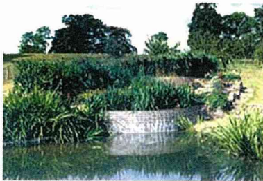
■圖4.造景優美的蘆葦污水處理系統。
