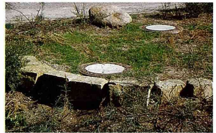
■水路中的擋水石用以減緩雨水迅速流失，水量大時也有造景的功能。
