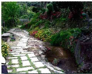
步道·坡坎·水溝
