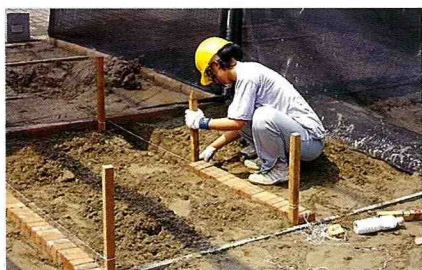
■紅磚緣石施工情形。
