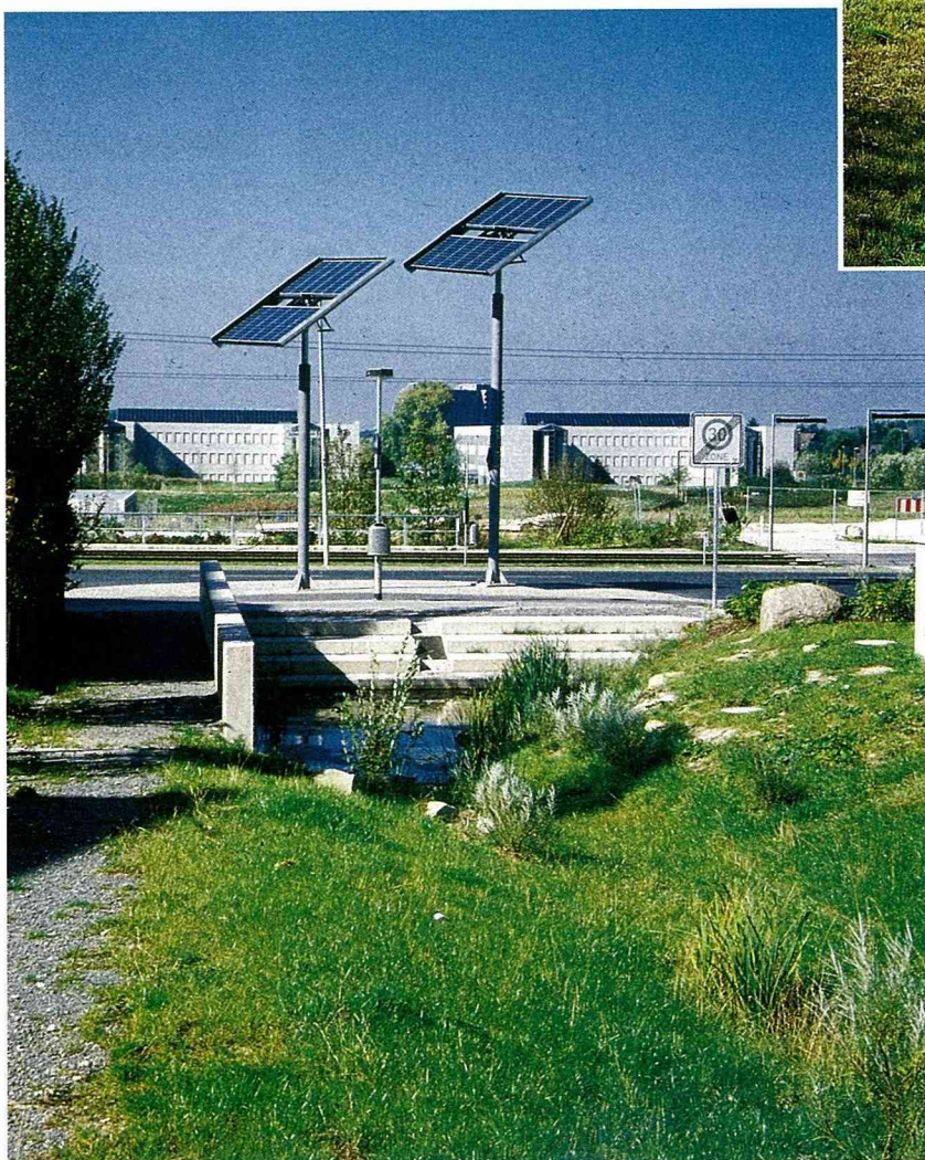
■水塘邊的太陽能幫浦，是要把來不及滲透而下流的地面水抽回排溝，讓水從上方再滲透一次。
