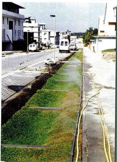
施工中的土溝
