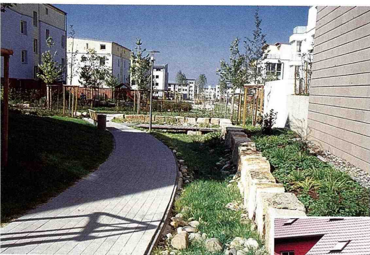
■建築牆邊的滲水帶取代了傳統的排水溝。
