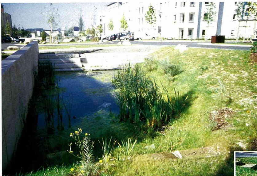
■主排水溝下方的集水塘。
