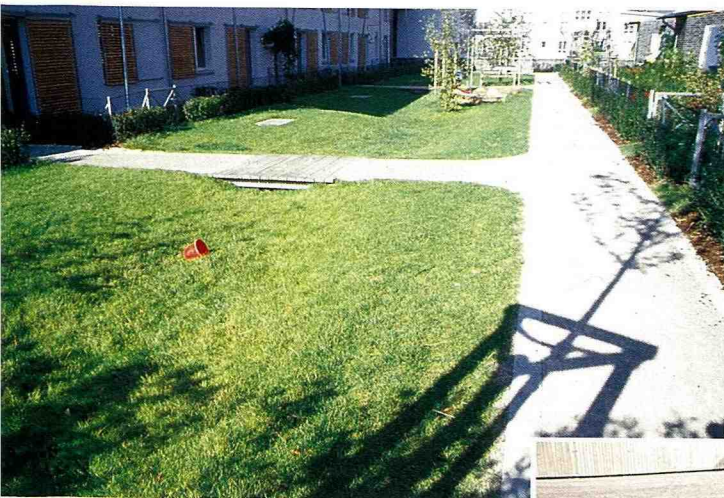
■你看的出來嗎？這一大片綠地的中央是具有排水功能的水溝。
