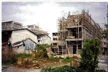
■鎮內持續進行的重建工程。
