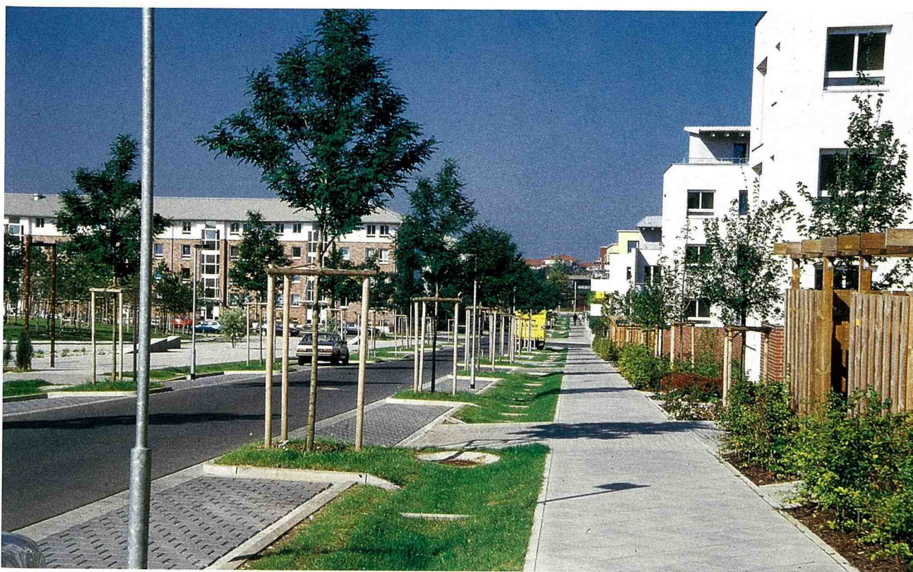
■完工後的滲水溝與停車場。
