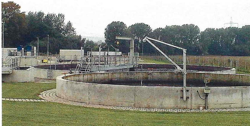
■德國鄉村傳統的污水處理場，硬體設施與整體景觀不協調。
