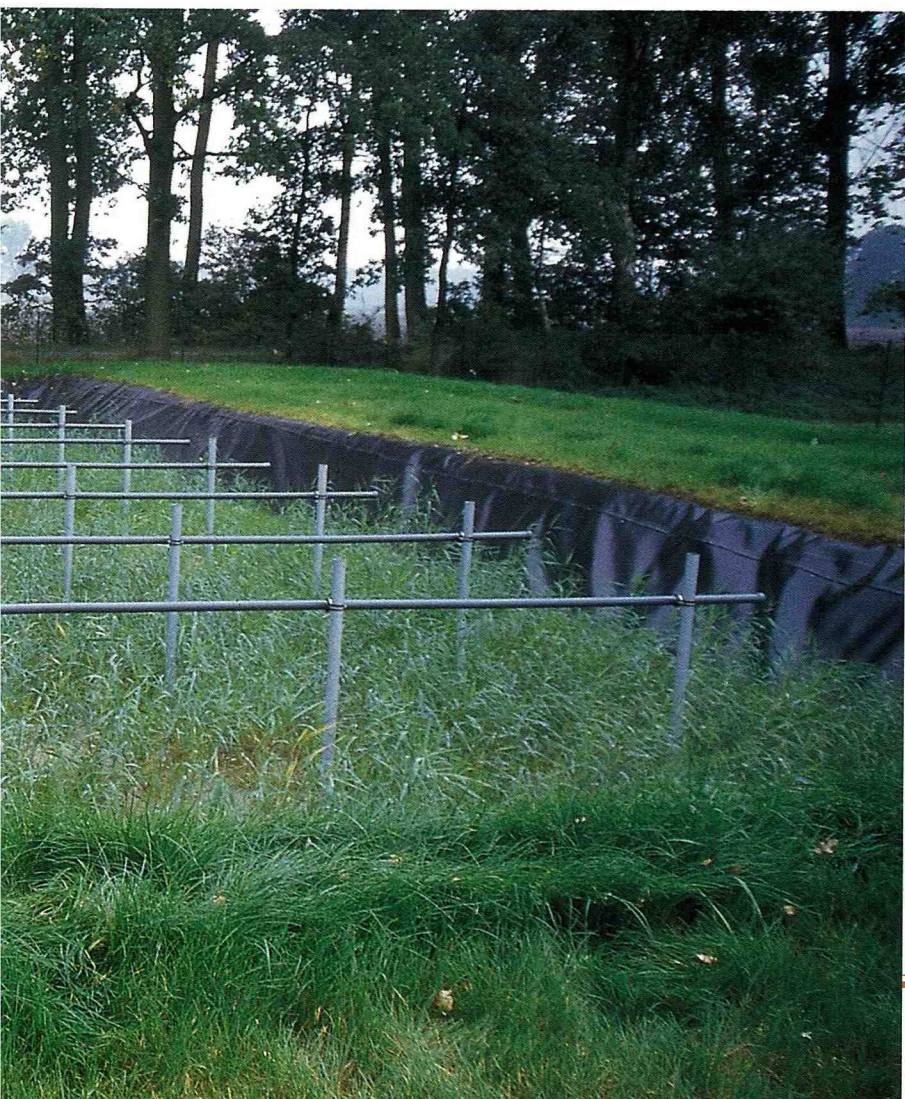
■威豪村的公共污泥處理池。
