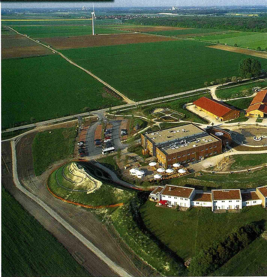
海曼農場全景及獨立的污水淨化系統。
