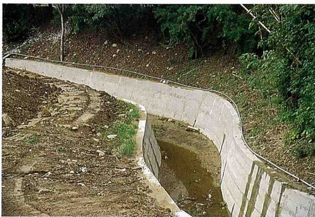
■ 打上水泥的野溪護岸。
