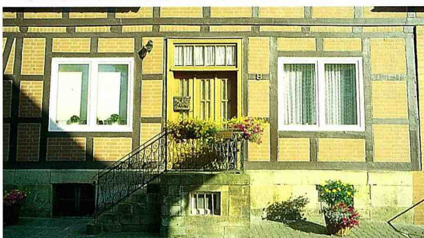
■ 德國老舊住宅的窗戶，更新為複層節能玻璃窗。
