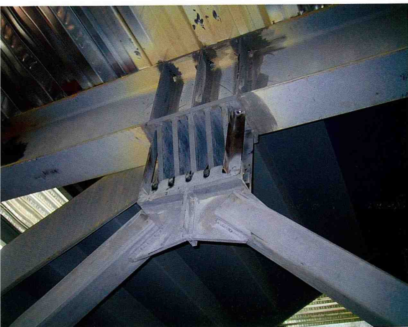
■ 增強減震功能的V型制震器。
