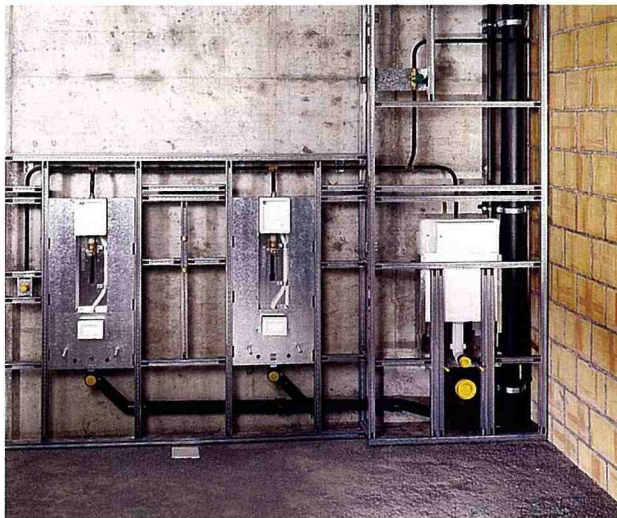
■ 無障礙衛浴設備的牆前配管工法。
