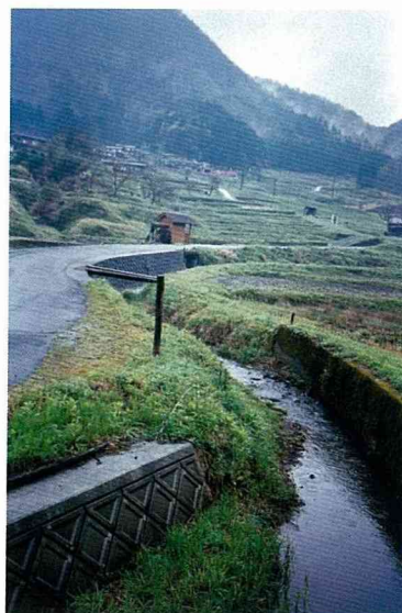
日本京都府美山町的大排溝。
