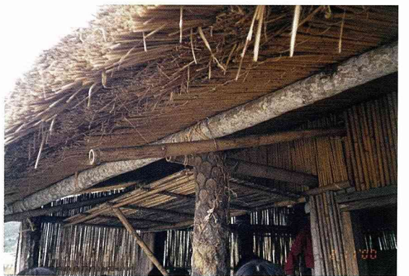
馬太鞍竹屋的屋頂結構。
