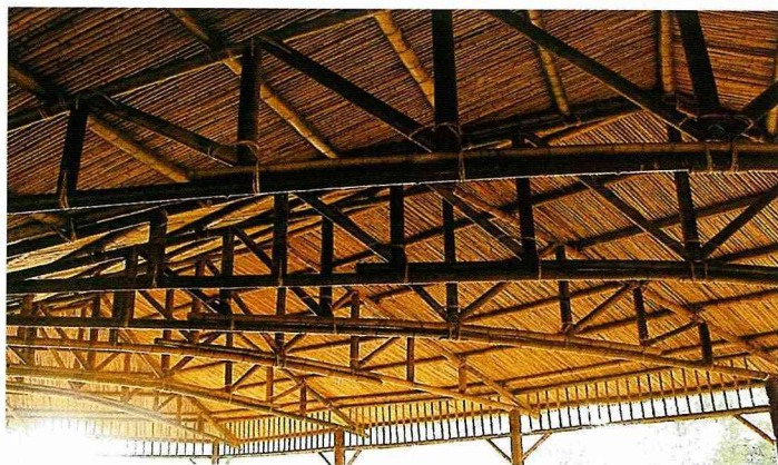
預組式竹構桁架之施工。
