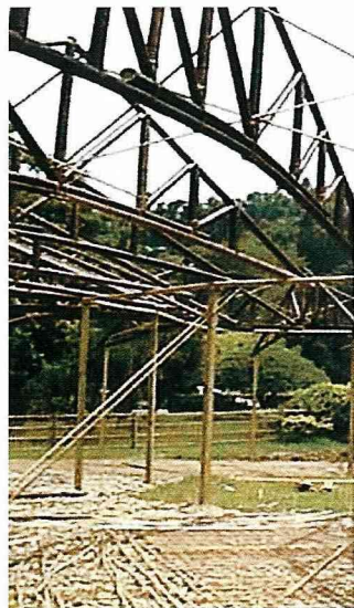
預組式屋頂桁架結構。
