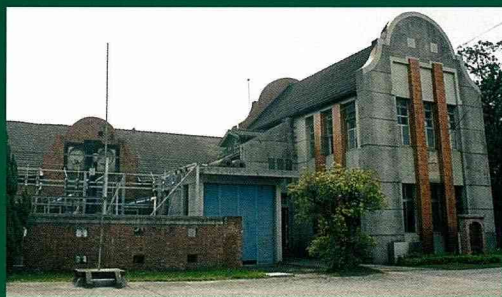
竹寮自來水取水站。
