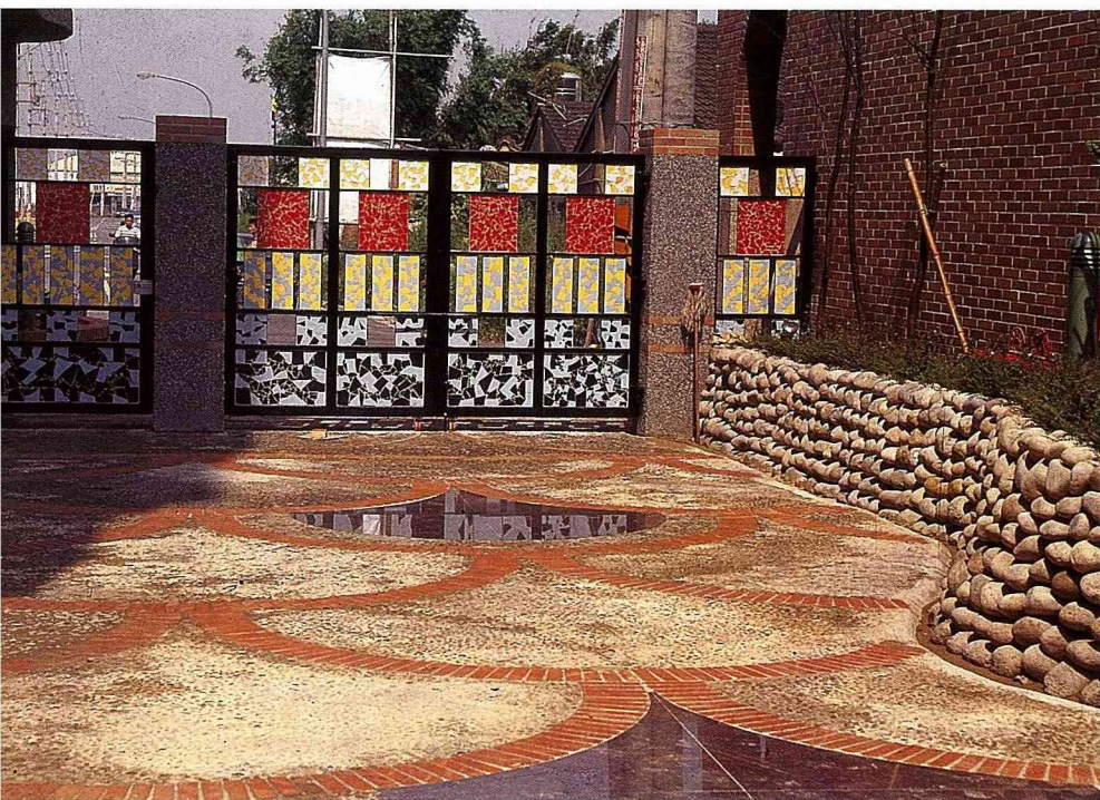
龍潭「親水大街」的卵石矮牆，象徵客家聚落傳統乾砌卵石的生態工法。
