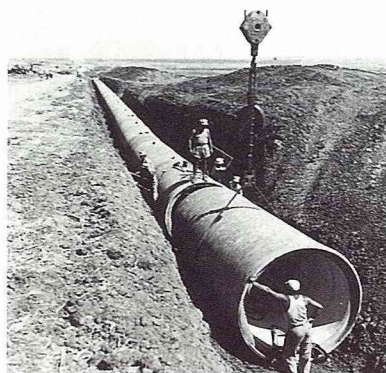
埋設管路，北水南運。
