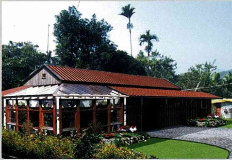
經改善面材，加上玻璃屋及大面開口，改良通風對流效果，增加了鐵皮屋的舒適性。 (圖：王曉偉)
