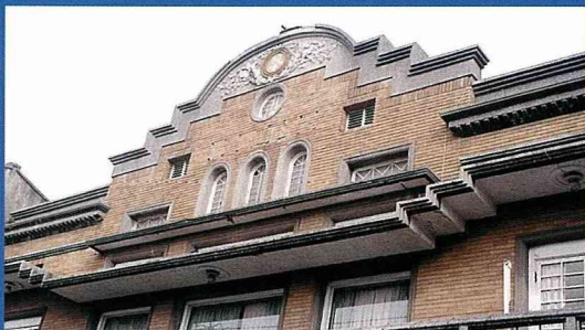
已經落幕的北港戲院，是典雅的現代主義建築結構。
