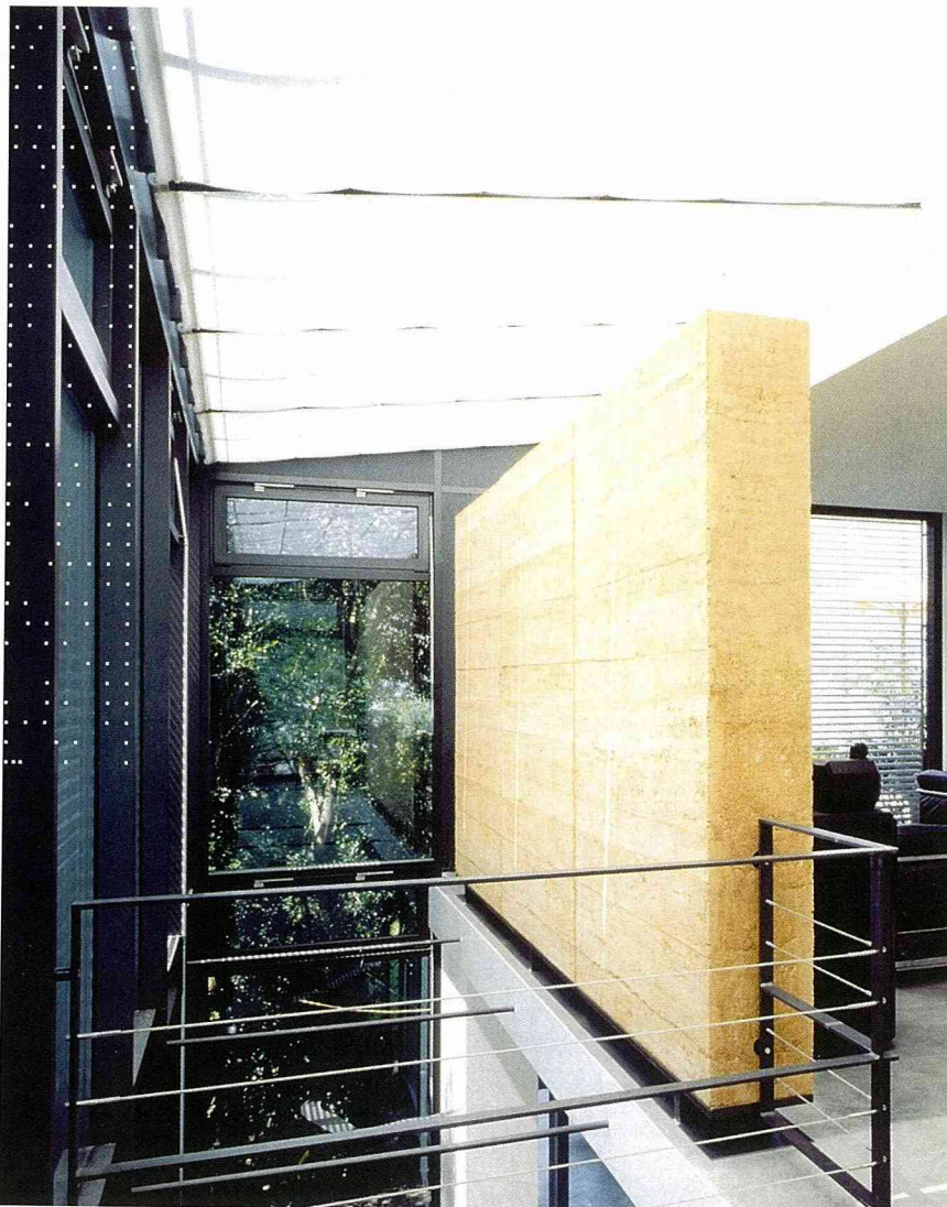
現代建築內的一道土牆。
