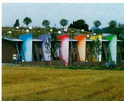
植草屋頂的生態建築
