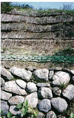
雇用在地人施工的上游崩塌地整治
