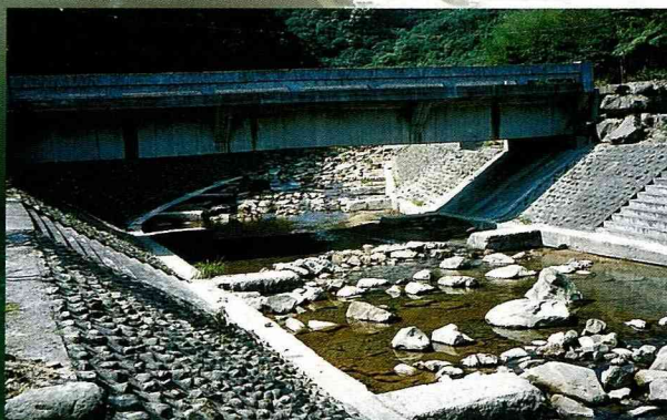
丁子蘭坑溪前段為早期的水泥護岸
