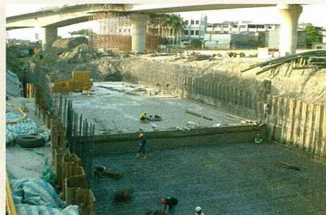
鹿寮大排溝的水泥底厚近1公尺（2004年2月11日）
