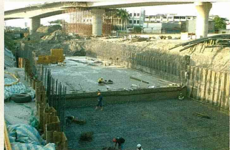
鹿寮大排溝的水泥底厚近1公尺（2004年2月11日）
