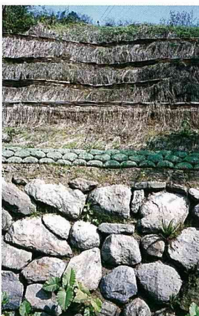
雇用在地人施工的上游崩塌地整治
