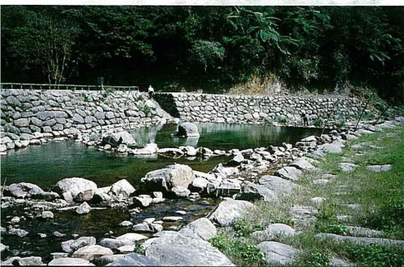
丁子蘭坑溪後段改進為砌石護岸
