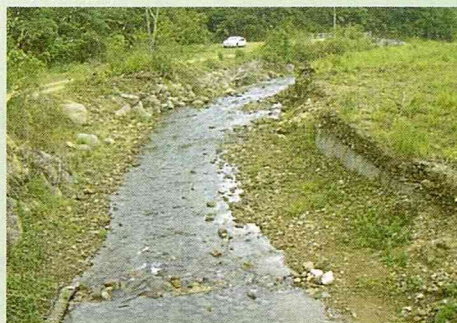
神農橋上游-施工前
