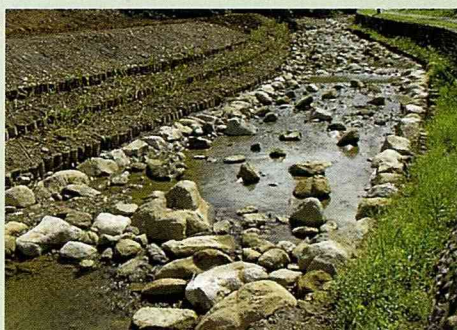
神農橋上游-完工後
