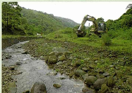
神農橋上游-施工中
