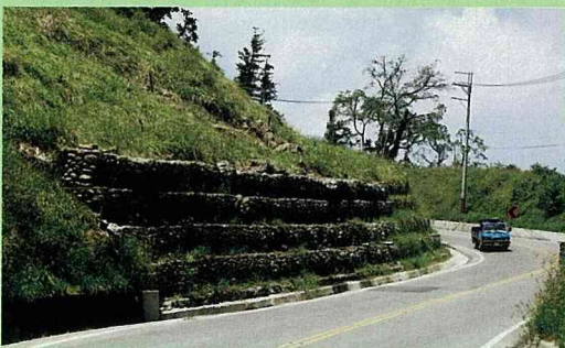
阿里山（台18號）公路中寮段，92年間曾發生走山的情形，經改道重建，以生態工法堆放蛇籠來保固道路邊坡
