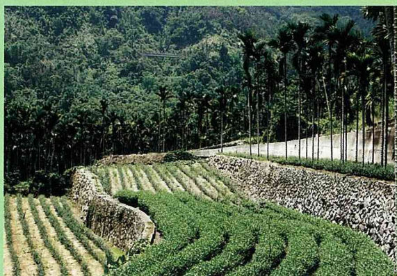
169號公路太和段旁的梯田，是採用砂岩石塊，以生態工法一層層堆砌而成，堅固耐用
