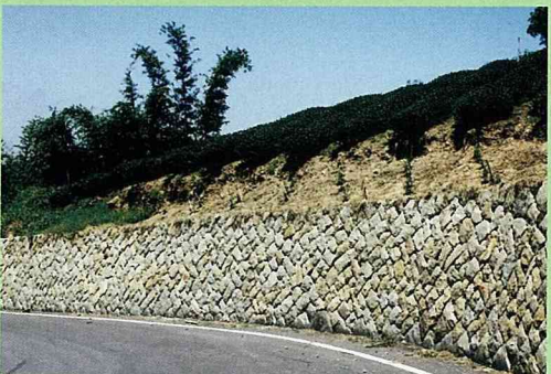
石桌村最近拓寬完成的道路邊坡，以石材堆砌建造
