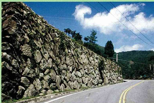
太和至豐山間149甲公路旁，利用生態工法將石塊堆砌成駁坎，安然通過「921」大地震及敏督利颱風「72水災」的考驗
