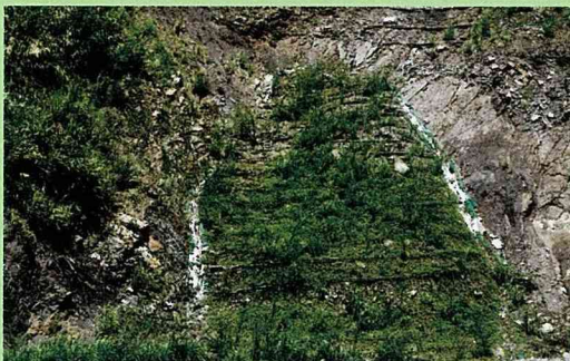
豐山村鄰近清水溪畔的山坡，採生態工法整治崩塌地
