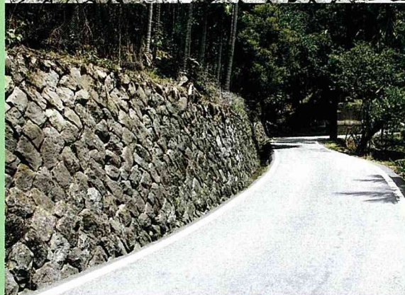
169號公路太和段，保留有50年歷史的駁坎與步道台階，以砂岩打鑿成石塊，採用生態工法堆砌
