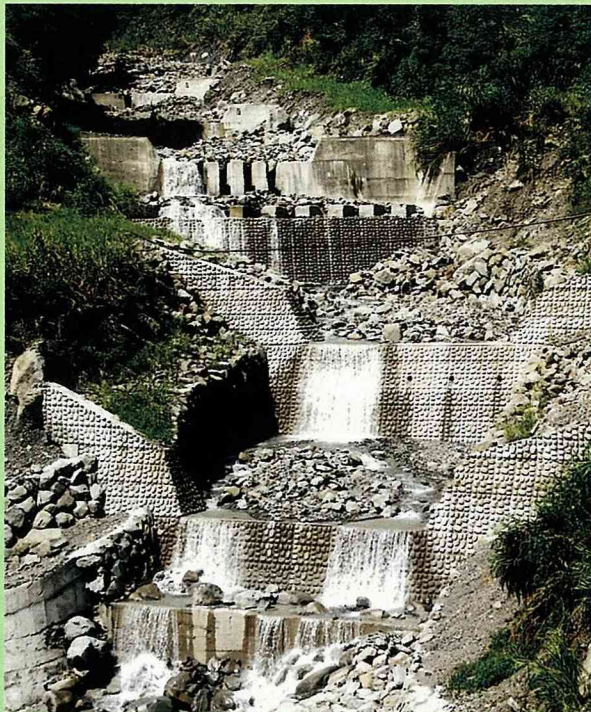
149甲公路來吉段山坡的山溝，有層層的攔沙壩設施保護，削弱大水與土石的破壞力，減輕災害發生
