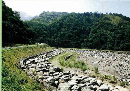
清水溪豐山段溪岸，有生態工法堆放的蛇籠與巨石，鞏固通往豐山村落的道路
