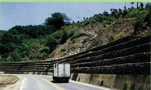
阿里山（台18號）公路，經公路局以生態工法堆放蛇籠，防範土石再崩塌
